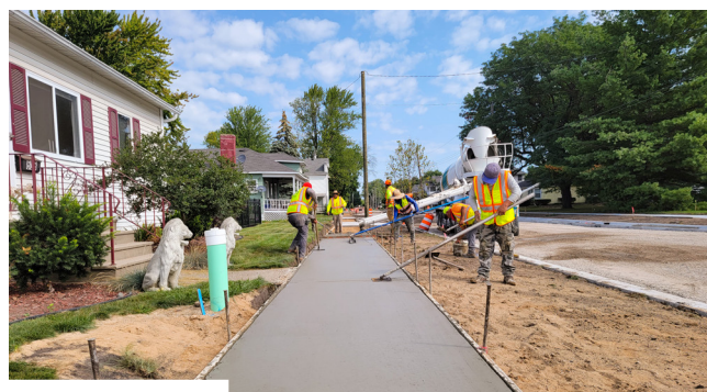
Crews pouring new sidewalks
